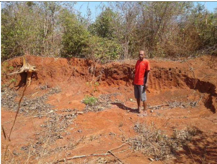
Le remblai d'emprunt
