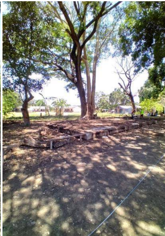
Photo 5 Dalle d'ancien bâtiment, côté Ouest
