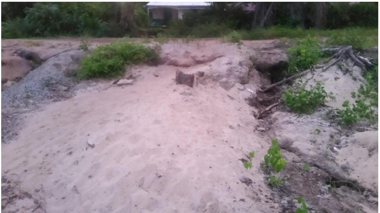
Vue de près côté Nord-Ouest
